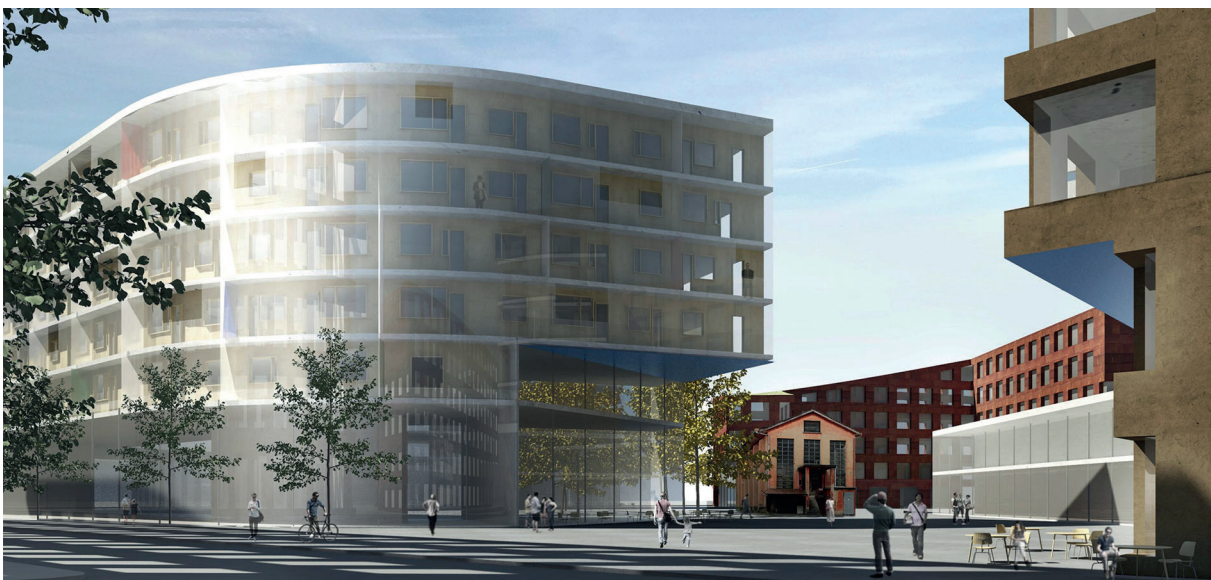
Eingangssituation des neuen ewl Hauptsitzes
