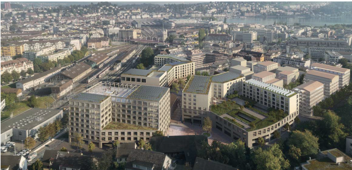
Blick auf das neue ewl Areal
