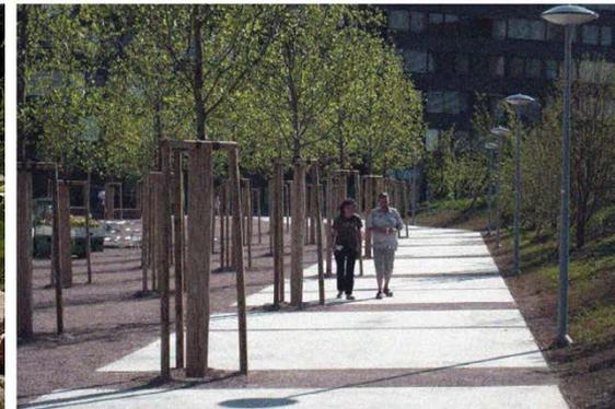
Erlentmattpark Basel, Ortbeton mit Fugen aus Splitt und Splittbeton, RVL
